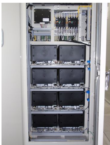
[バッテリーパック 50 kWh 実装状態]
